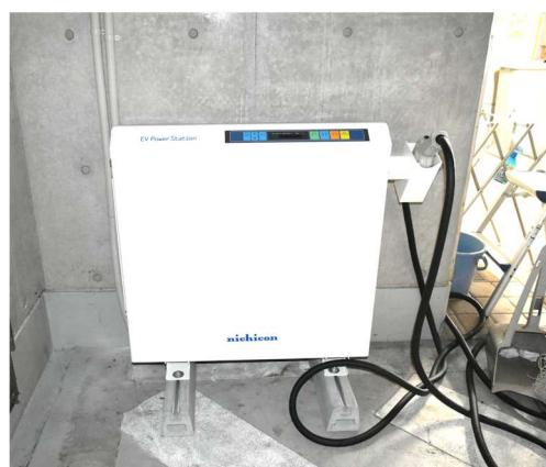
すみなす会本部地下駐車場に設置しました。災害時には電気自動車にハンドルを接続し、その電気を本部に送ります。情報の維持と外部との通信に役立てられます。
