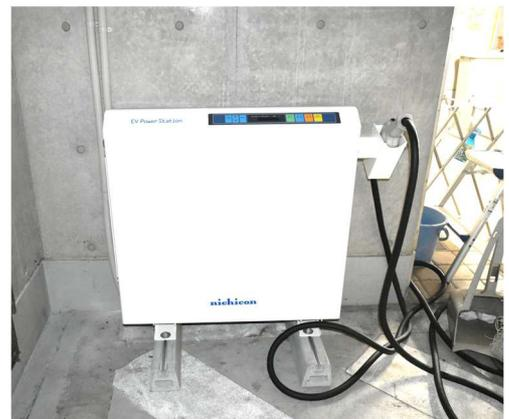
すみなす会本部地下駐車場に設置しました。災害時には電気自動車にハンドルを接続しその電気を本部に送ります。情報の維持と外部との通信に役立てられます。
